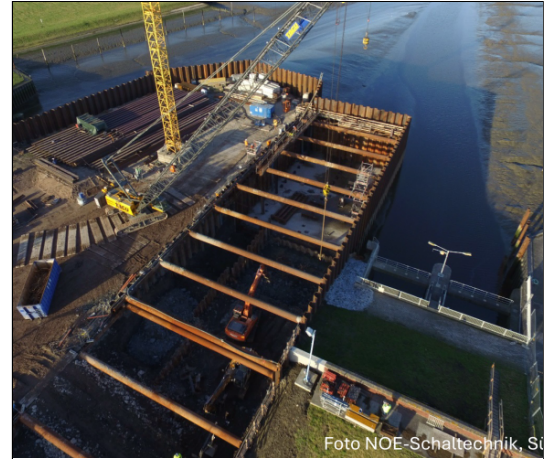
Foto NOE-Schaltechnik, St
